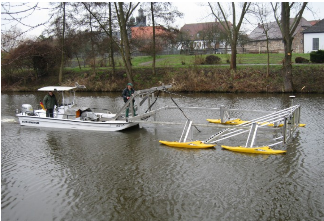
Beispiel einer Kampfmittelondierung durch die Fa. Schollenberger, Celle
